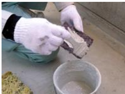
FCコートまたはパターン液を 刷毛でスポンジに付けます
