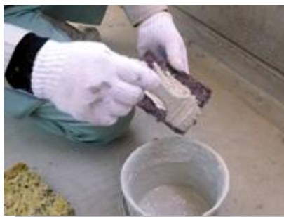
FCコートまたはパターン液を 刷毛でスポンジに付けます
