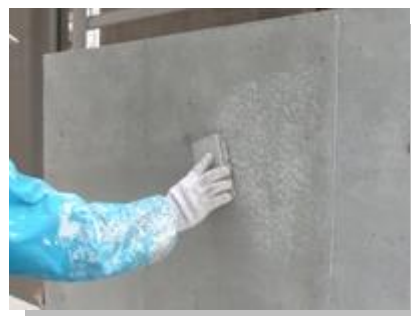
施工面に軽く叩くようにして 模様を付けます
